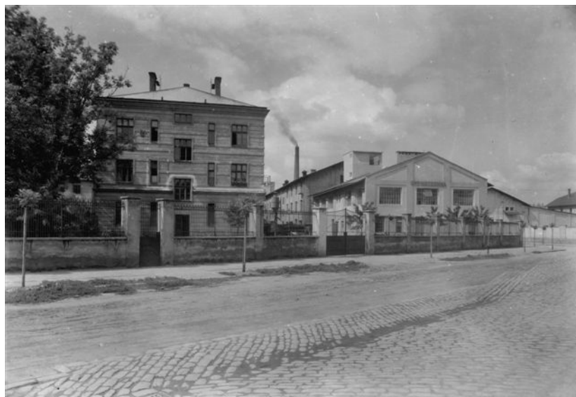
Obr. 3. Historická budova Optikotechny [vlastní]
