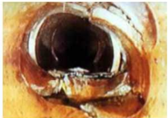
Obr. 6 Příklady zborceného potrubí (kameninové potrubí)[8]
