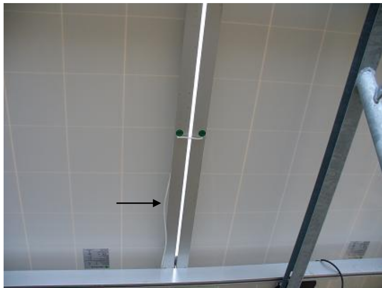
Obr. 30. Propletení hlídaného vedení mezi panely
