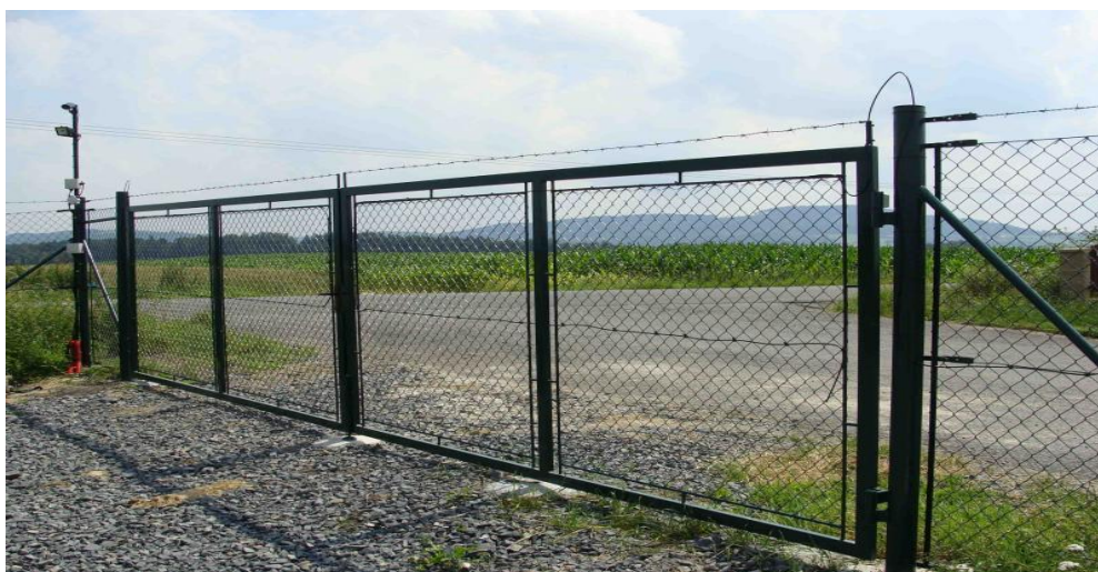
Obr. 4. Vstupní brána dvoukřídlová
