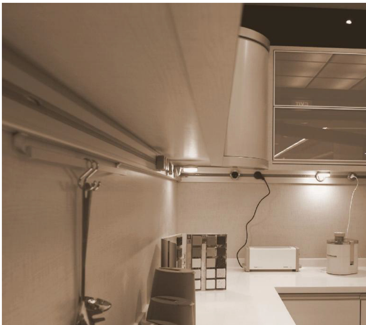
Obrázek 32 Eubiq instalovaný v kuchyni
