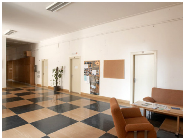
Obrázek 22 Krycí lišta plastová bílá rozvádí kabely po celé místnosti
