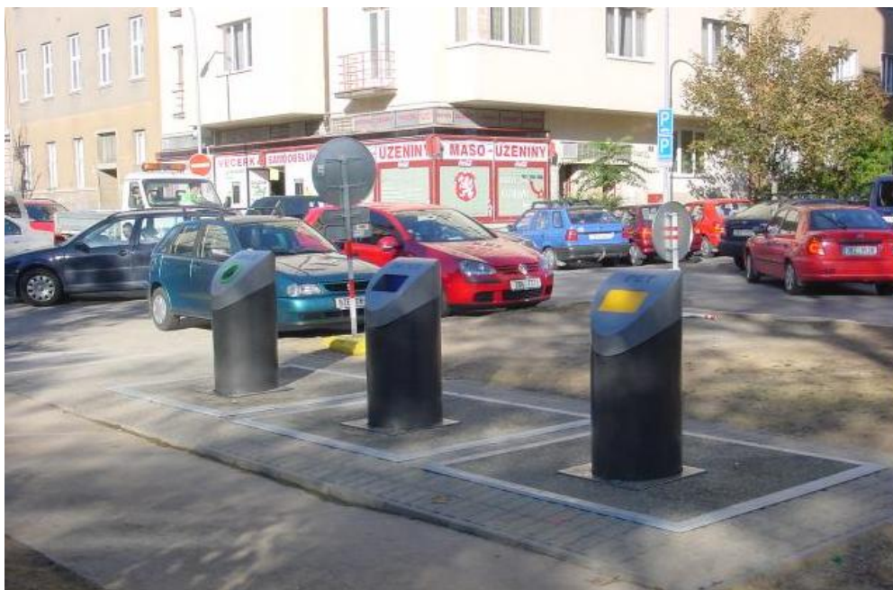
Obr. 30 – Jedno ze stanovišť podzemních kontejnerů v Brně [37]
