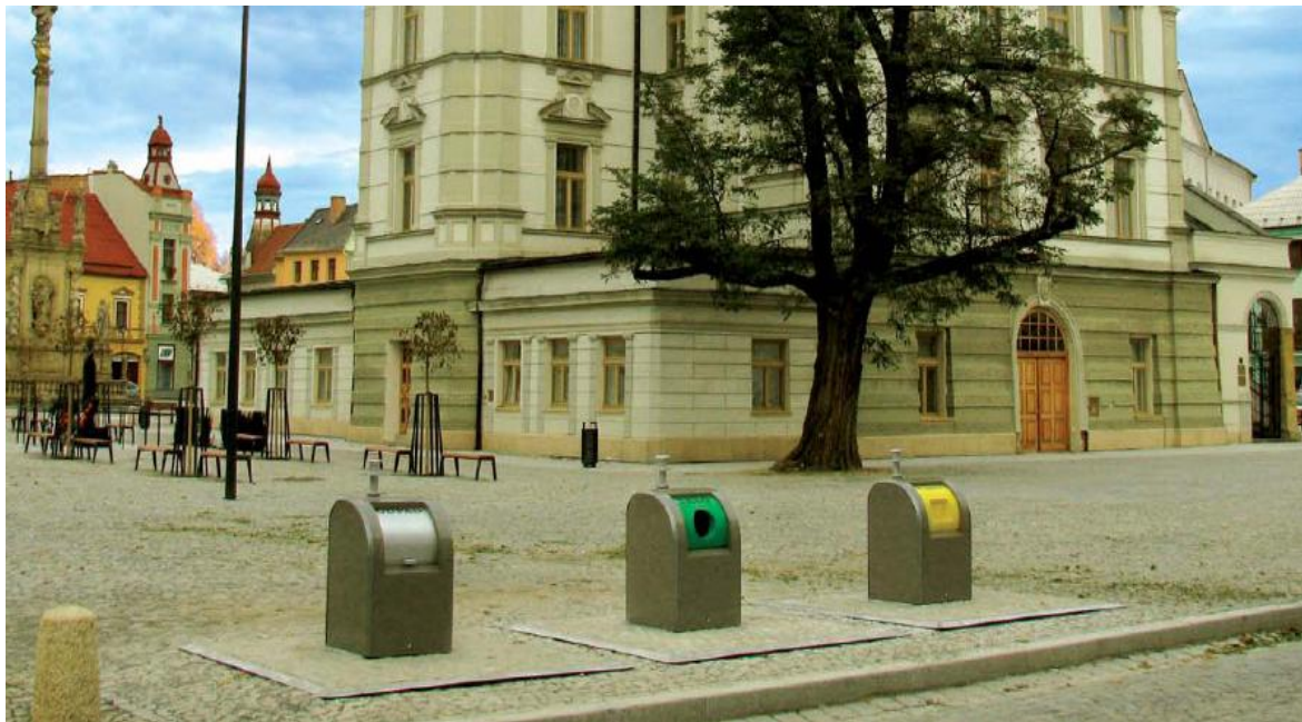
Stanoviště podzemních kontejnerů v Uničově
