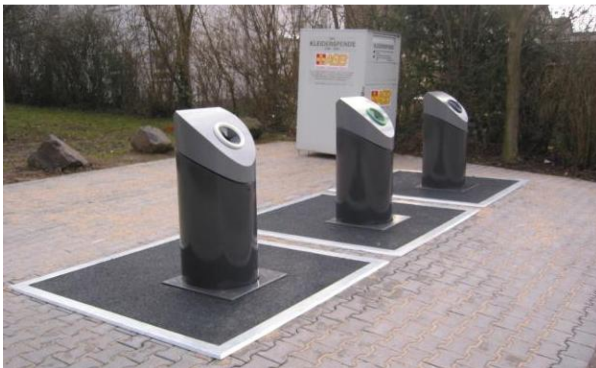
Obr. 16 – Stanoviště zcela zapuštěných kontejnerů [60]
