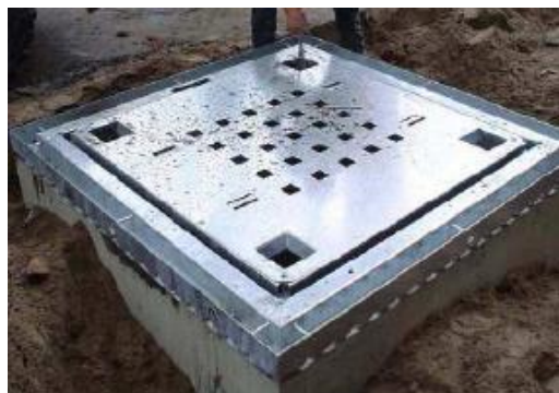
Obr. 19 – Bezpečnostní podlaha šachty kontejneru (1) [38]
