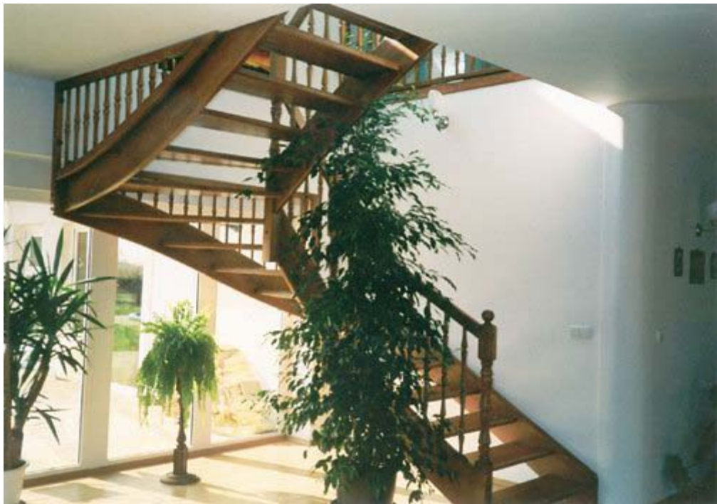
Obr. 7. Dřevěné samonosné schodiště. [15]
