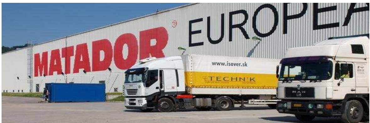
Obr. 8 Púchovské distribučné centrum [14]
