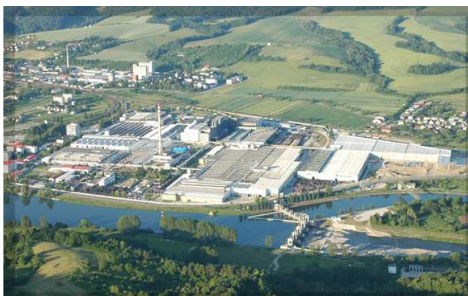
Obr. 6 Náhľad na areál spoločnosti Continental Matador Rubber, s. r. o. [20]
