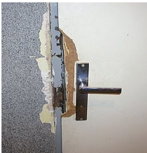
Obrázek 9 Detail vypáčených dveří [18]
