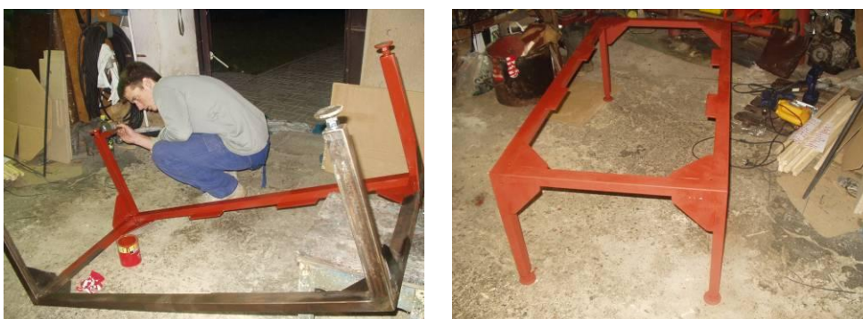
Obr. 9 a,b -Železný podstavec a nátěr základní barvou.
