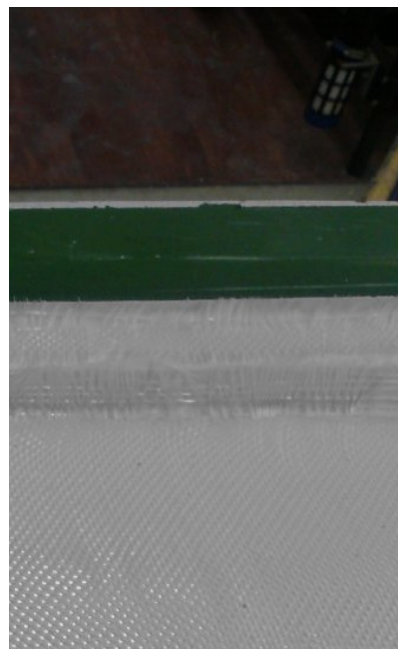
Obr. 47: Položení krajní části výztuže
