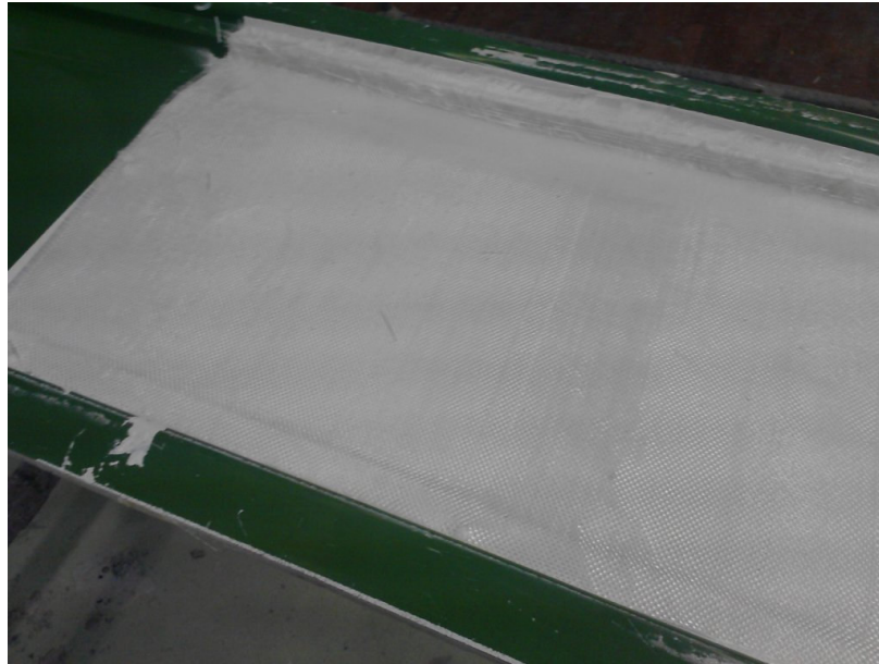
Obr. 46: První vrstva výztuže
