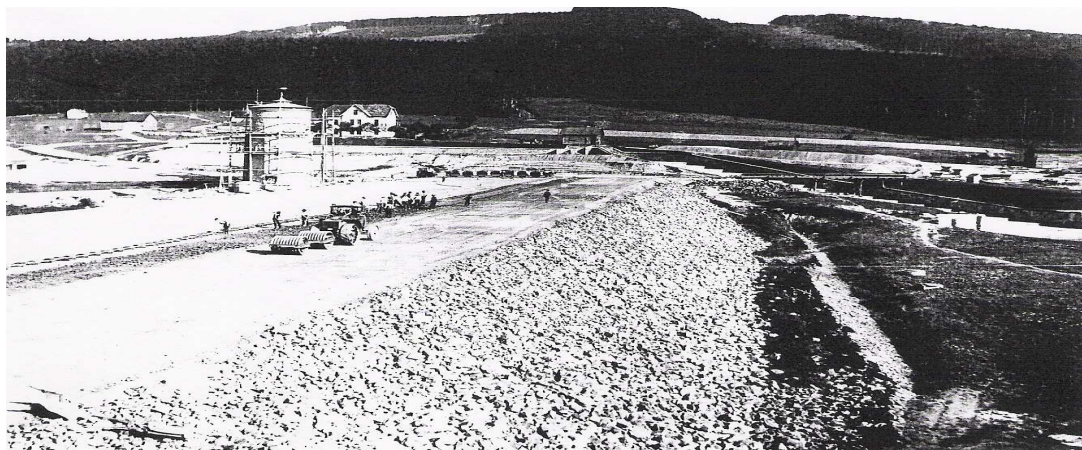
Obr. 8 Stavba hráze vodní nádrže Luhačovice [Zdroj: Vlastní]
