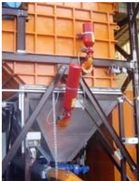
Obr. 32. Návrh instalace HRD bariéry
