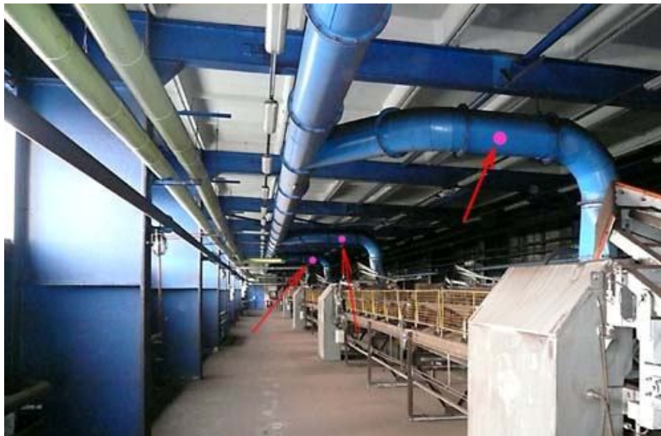
Obr. 33. Návrh instalace HRD bariéry
