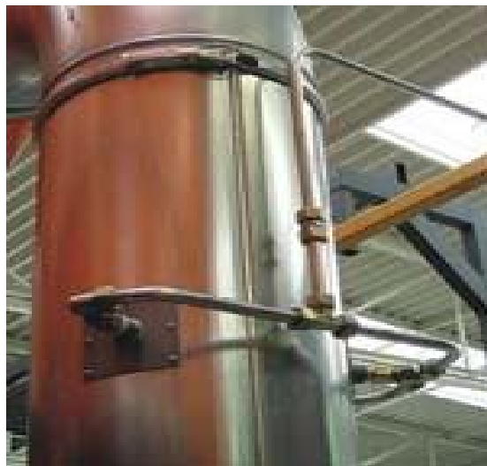
Obr. 29. Systém zhášení jisker [13]
