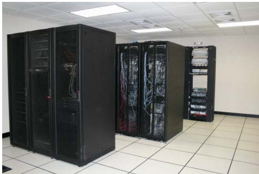
Obrázek 14 Serverová místnost se serverovými skříněmi [11]
