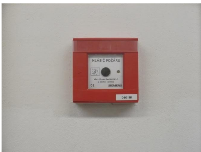
Obr. 8. Tlačítkový hlásič FDM 223.
