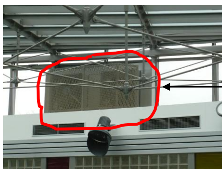
Obr. 22. Ventilátory nuceného odvodu tepla a kouře.
