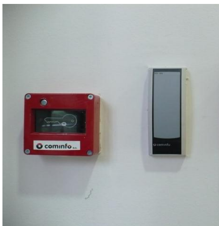
Obr. 17. Skříňka pro uložení klíče s externí snímací hlavou.
