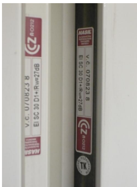
Obr. 23. Identifikační štítek požárních dveří.
