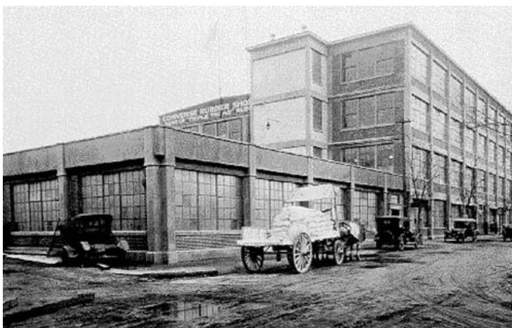
Obrázek 72 První tovární budova firmy Converse (1910)
