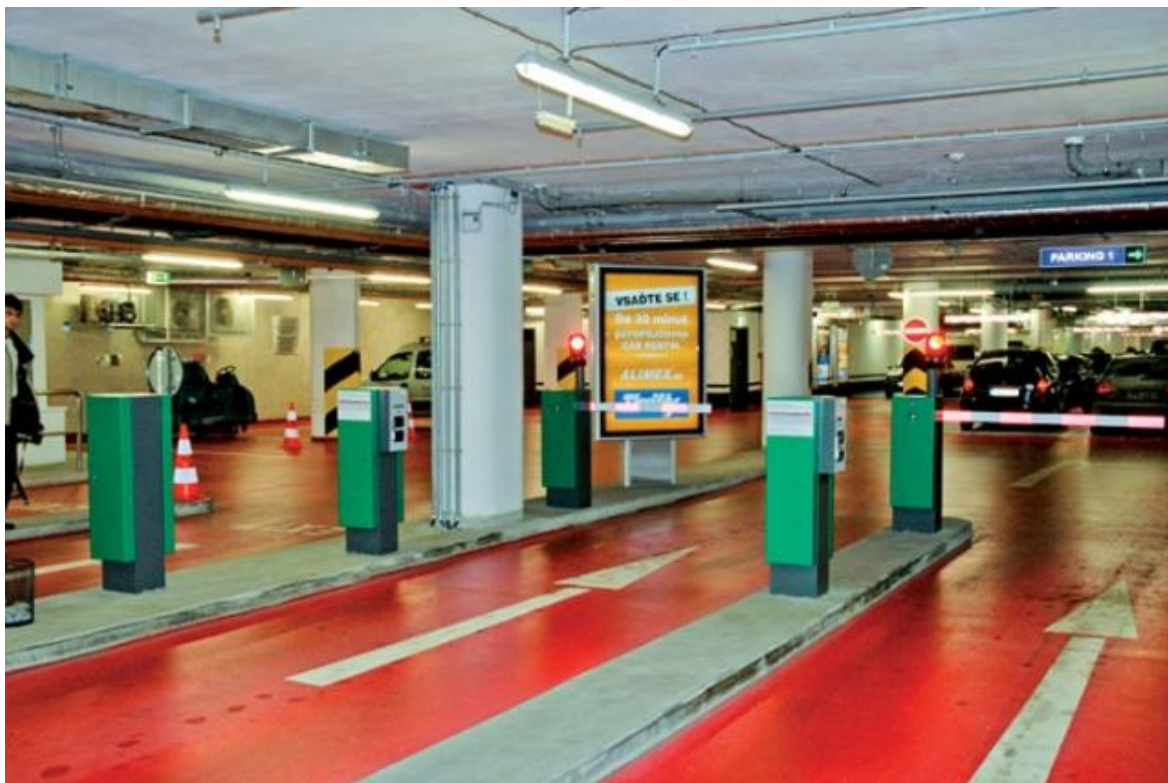
Obr. 15. Přístupové terminály systému Green center v garáži obchodního centra Palladium (3)
