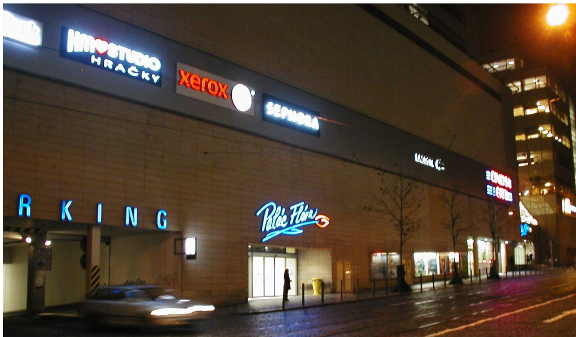
Obr. 1. Palác Flóra s vjezdem do podzemních garáží
