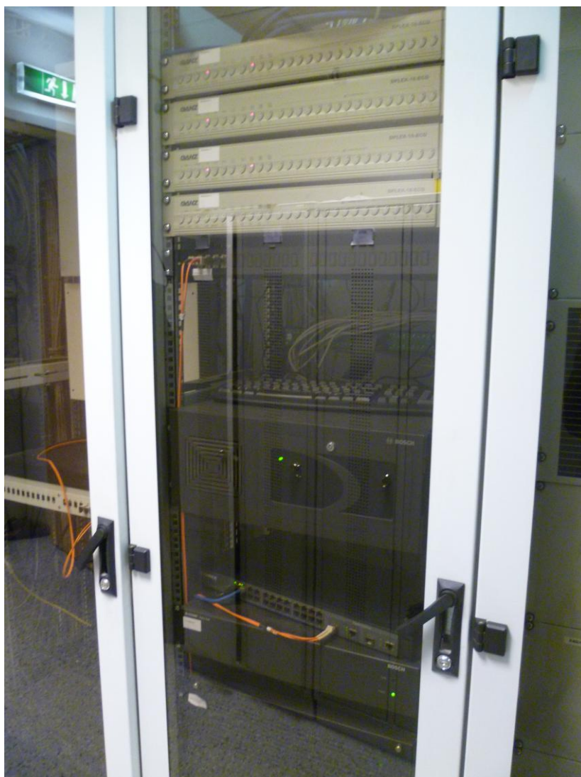
Obr. 5. Racková skříň s prvky systému CCTV
