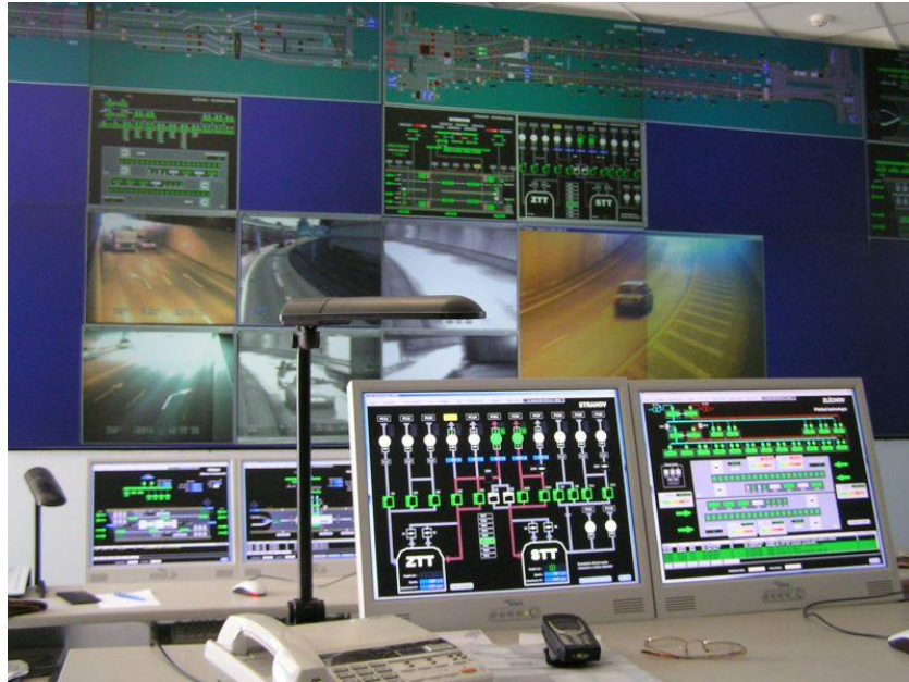
Obr. 26 - řídicí systém Kerberos ve velínu Strahovského tunelu [28]
