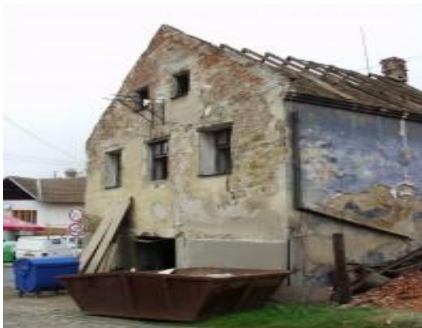
Obr. 3 Hotel před rekonstrukcí [webové stránky]
