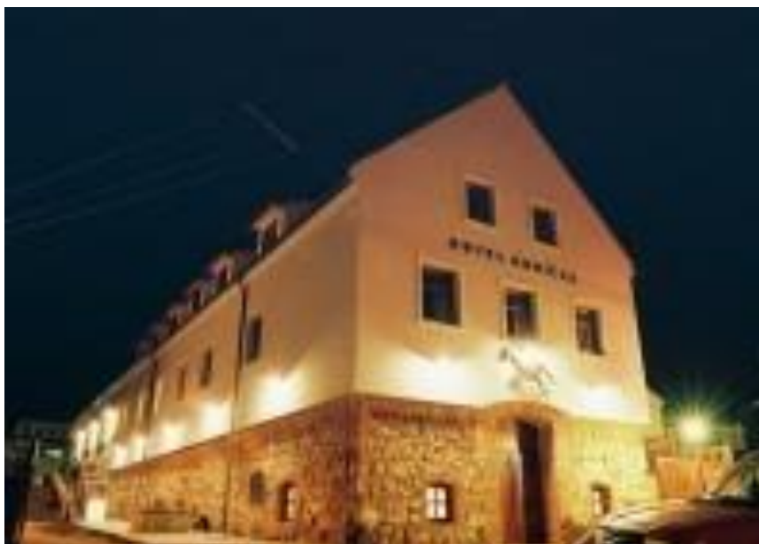
Obr. 4 Hotel po rekonstrukci [webové stránky]
