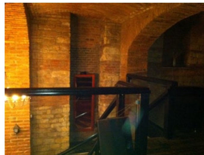
Pravý okraj sálové galerie se schodištěm do spodního patra
