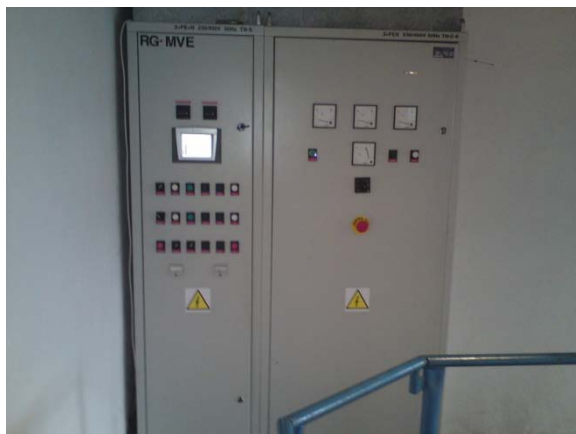
Obrázek 46: Uzavřený rozvaděč s řídicím systémem
