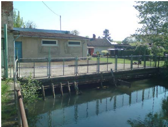
Obrázek 40: Pohled na vtokovou část elektrárny
