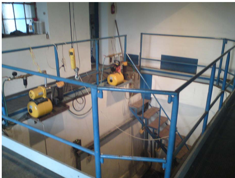
Obrázek 44: Pohled do nadzemní části strojovny
