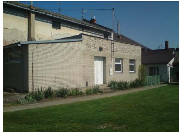
Obrázek 41: Boční pohled na elektrárnu
