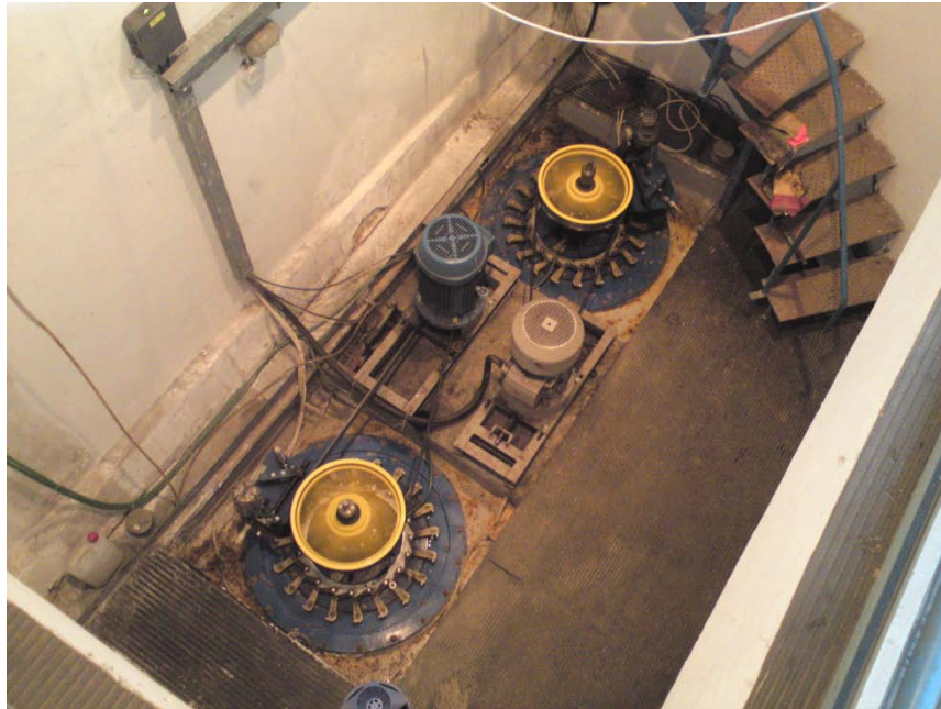
Obrázek 45: Pohled do podzemní části strojovny
