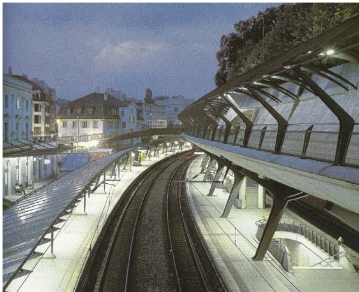
Obr. 15. Pohled na kolejiště nádraží Stadelhofen
