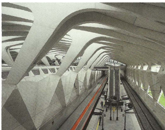
Obr. 17. Kolejiště vysokorychlostních vlaků
