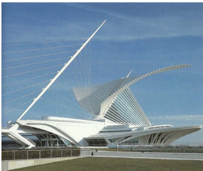
Obr. 22. Stavba s otevřenou sluneční clonou
