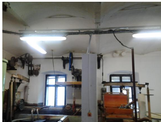
Obr. 26. Zbytek centrální transmise (VI. foto)
