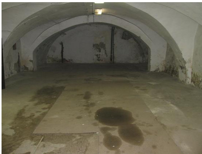
Obr. 7. Původní stav sklepních prostor (Zlínský Švec, 2013)
