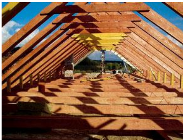
Obr. 11 Hambáľkový krov (Drevopal, s. r. o., 2010)
