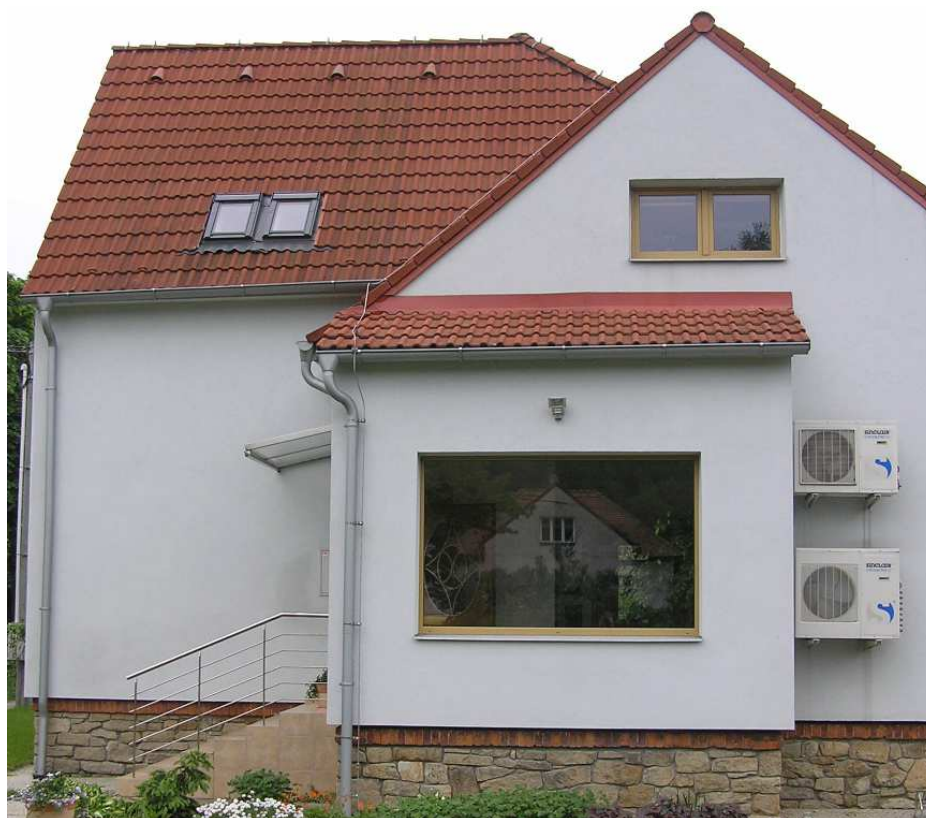
Obr. 15: Velké okno v přízemí na severním průčelí budovy
