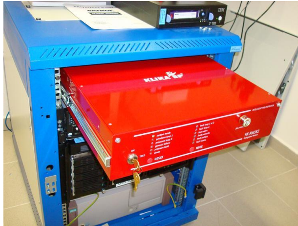
Obr. 16. FK-RACK ® v serverové skříni
