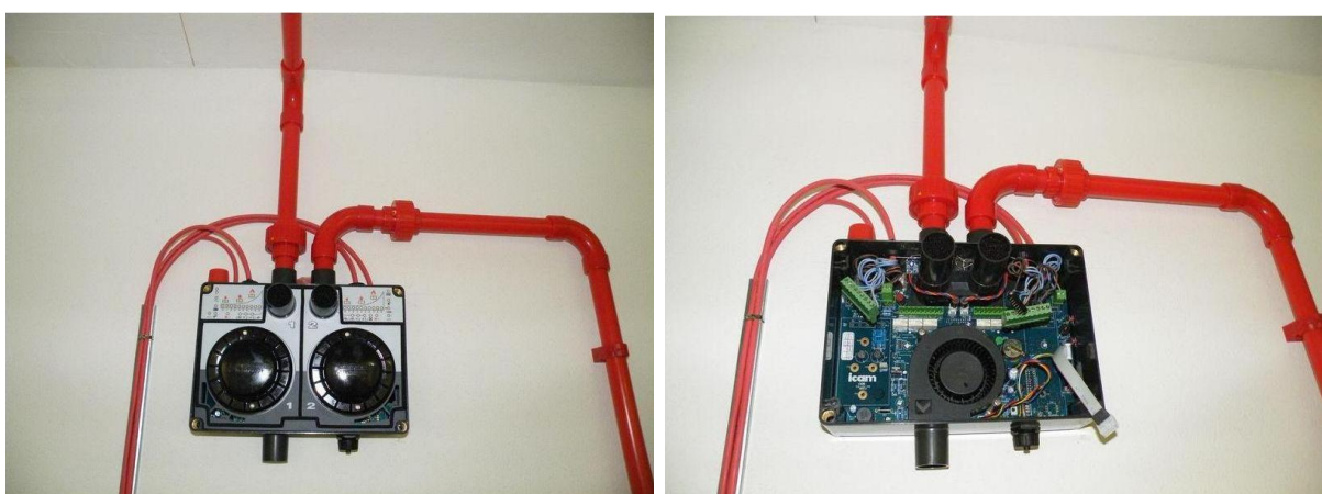
Obr. 9. Nasávací kouřový detektor
