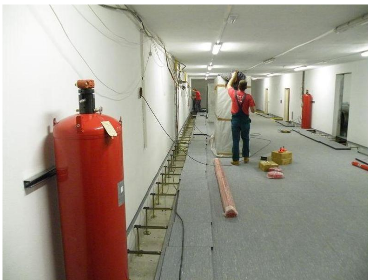
Obr. 5. Umístění lahví s plynem FM-200
