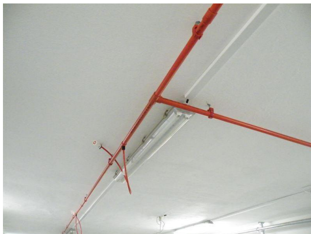
Obr. 10. Rozvětvení nasávacího potrubí
