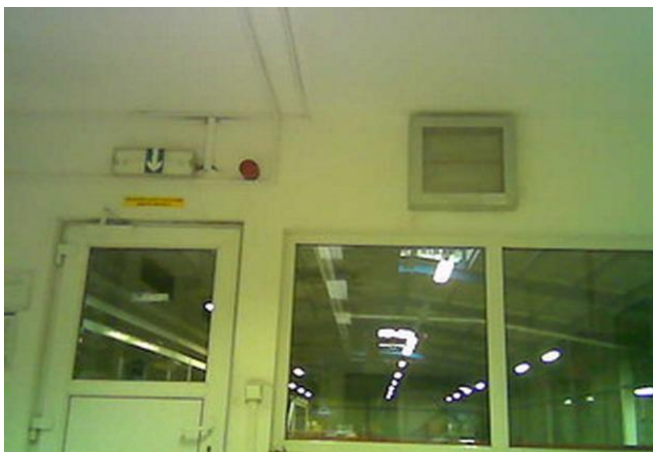
Obr. 7. Přetlaková klapka směřující do vedlejší místnosti
