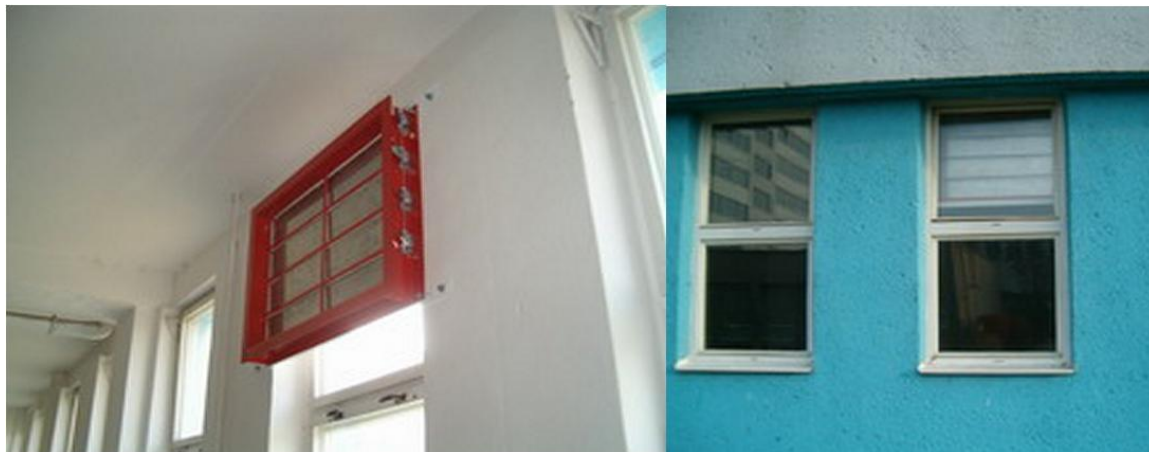
Obr. 8. Přetlaková klapka směřující ven z objektu
