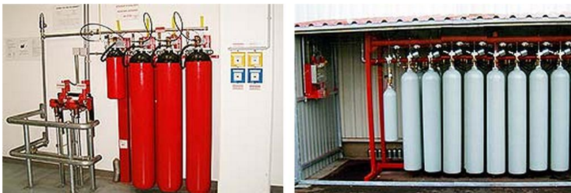
Obr. 4. Uložení tlakových lahví s hasivem
