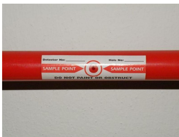
Obr. 11. Detail sacího bodu
