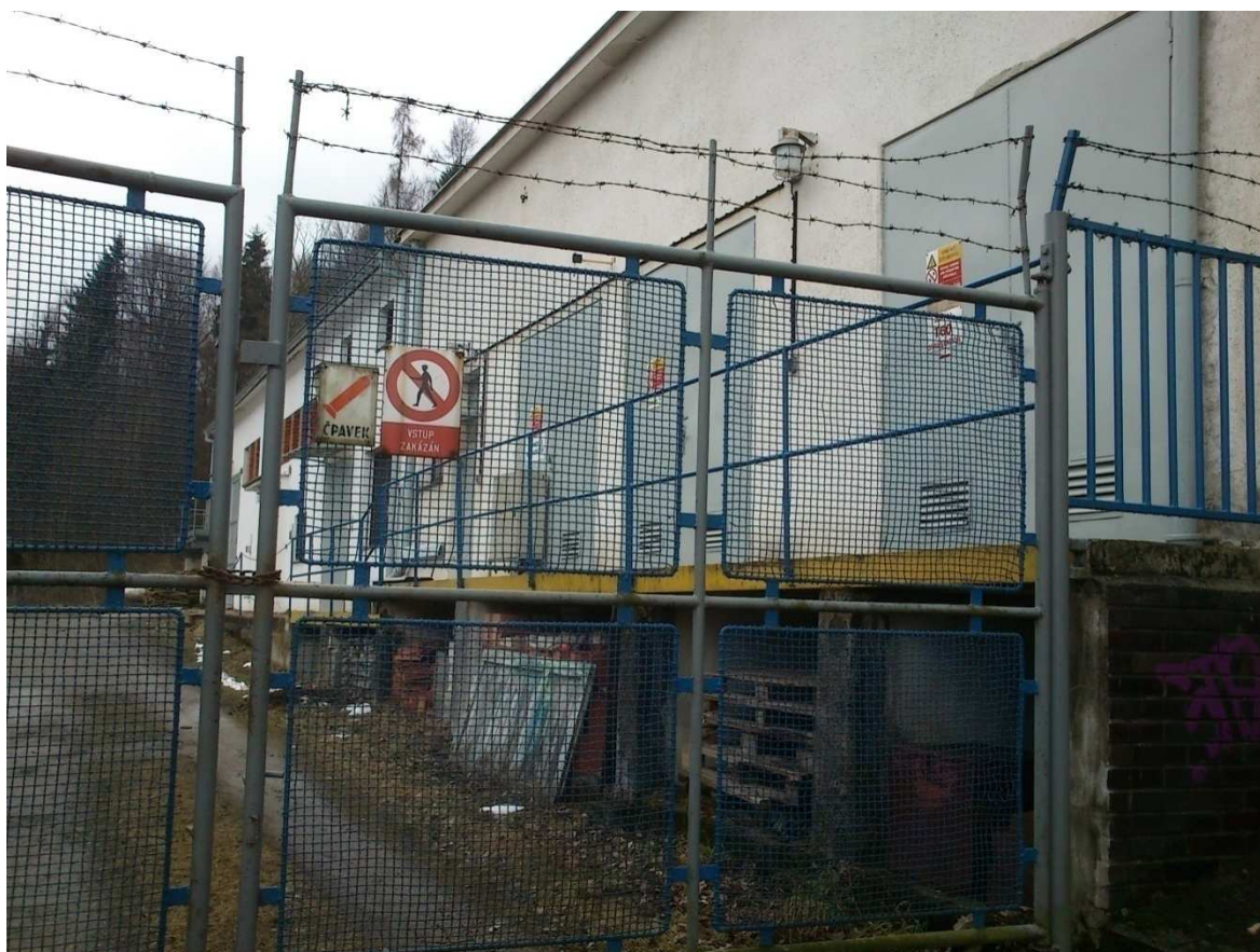
Obr. 4. Fotografie objektu strojovny Zimního stadionu Luďka Čajky
