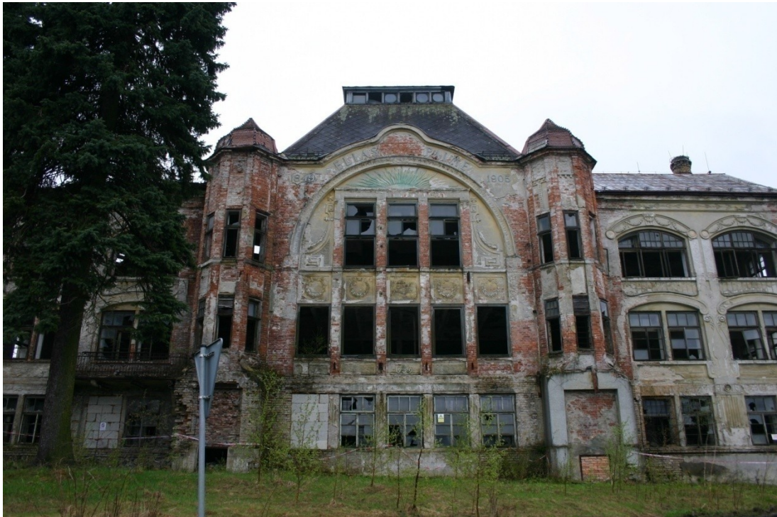
Obr. 22 Průčelí hlavní budovy
