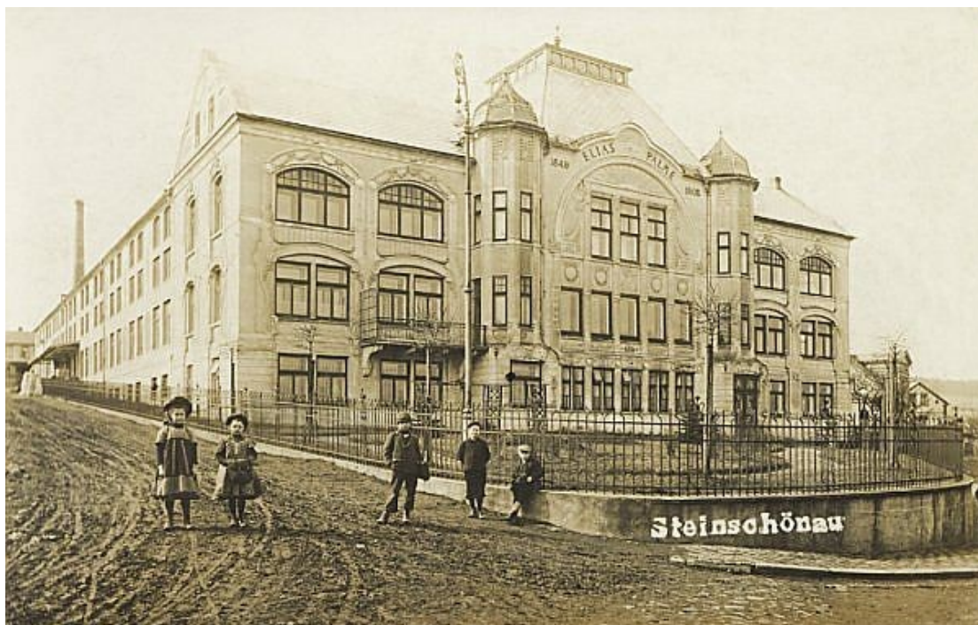
Obr. 17 Přední část budovy Elias Palme
