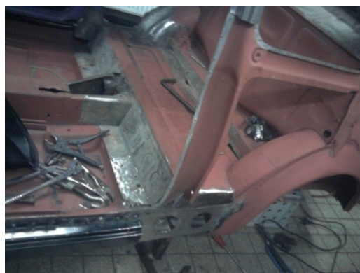
Obr. 6 Práce na prazích před přivařením podlahy
