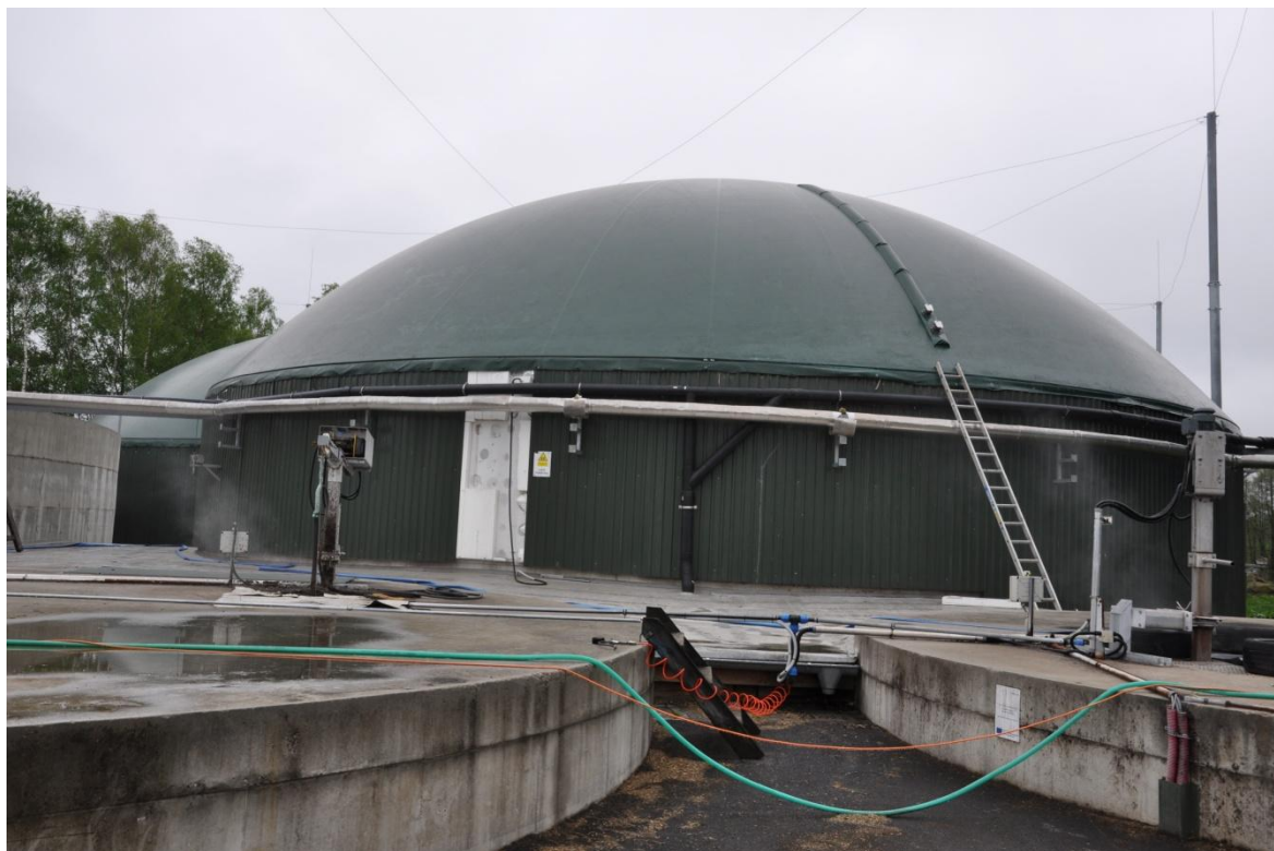
Obr. 45: Fermentory s fóliovým plynojemem a betonové vstupní jímky (v popředí)
