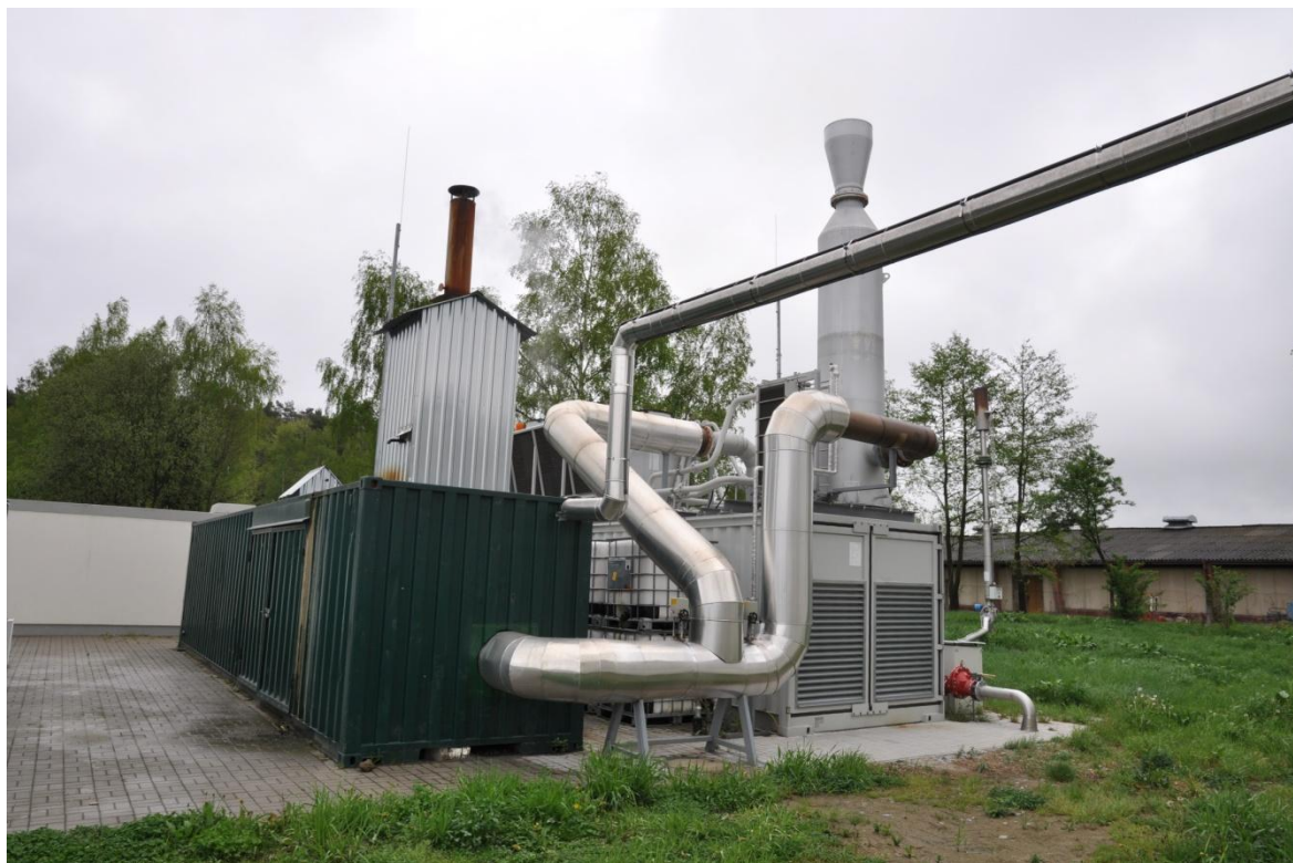
Obr. 51: Kontejner s KGJ (vpravo) a kontejner s vyvíječem páry (vlevo)
