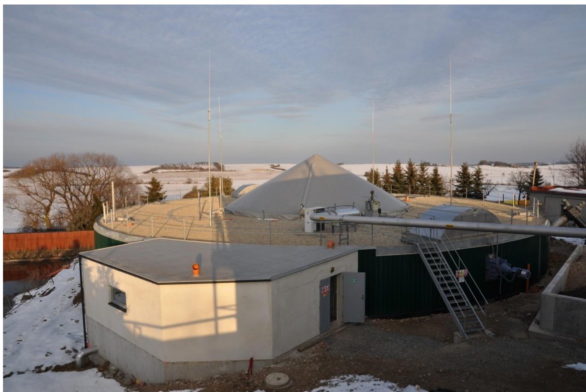
Obr. 33: Fermentor s nízkotlakým zásobníkem plynu a technický sklep
