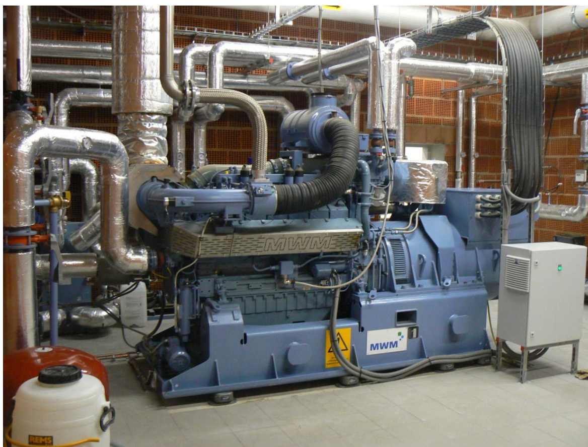
Obr. 38: Kogenerační jednotka BPS Vícov
