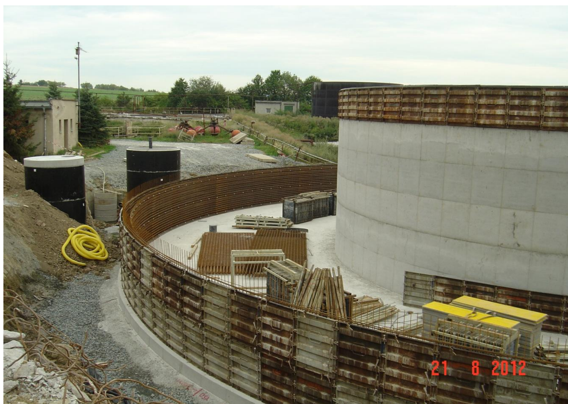
Obr. 30: Výstavba fermentorů
