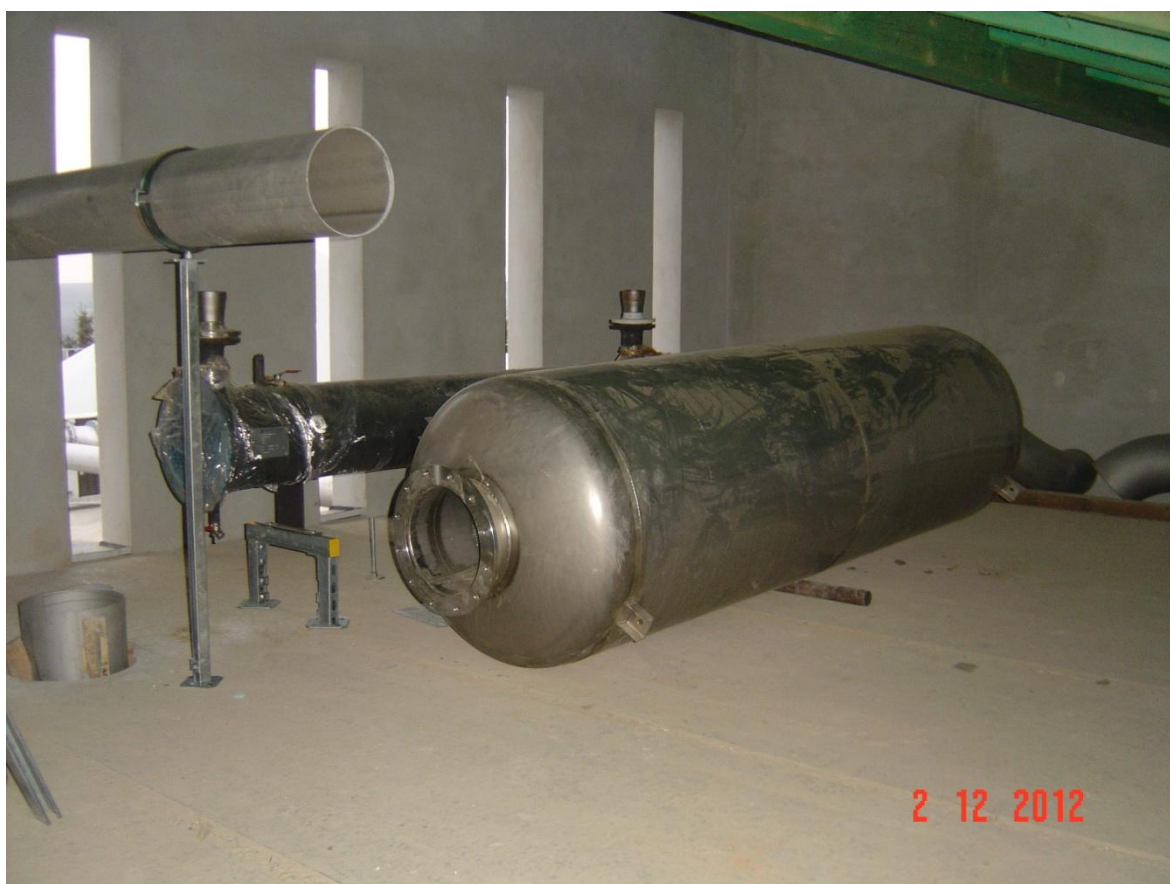
Obr. 32: Výměník tepla na výfukovém vedení
