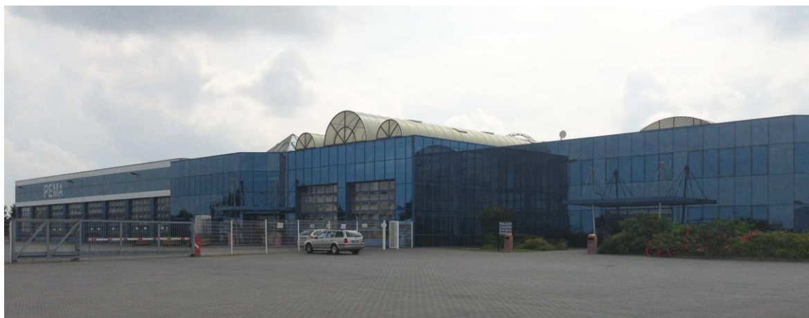
Obrázek 8 Budova servisu PEMA Praha s.r.o. (PEMA Praha, 2013)
