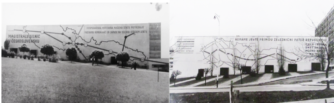
Obr. 73: Boční stěny Velkého kina s velkoformátovou reklamou dostavby infrastruktury v ČSR
