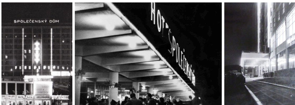
Obr. 42: Neonové osvětlení Společenského domu
