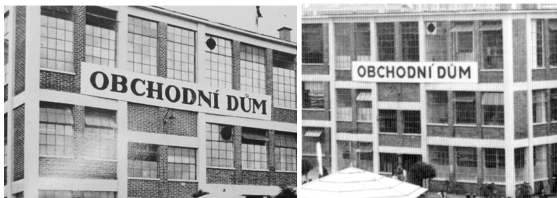
Obr. 7: Původní a novější označení starého obchodního domu (Tržnice)
