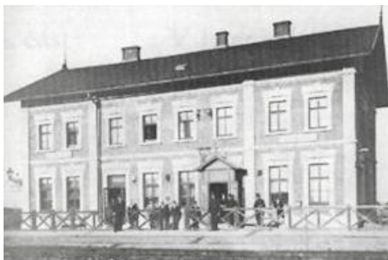
Obrázek 1 Železniční zastávka v roce 1882 (Otrokovice, ©2013)
