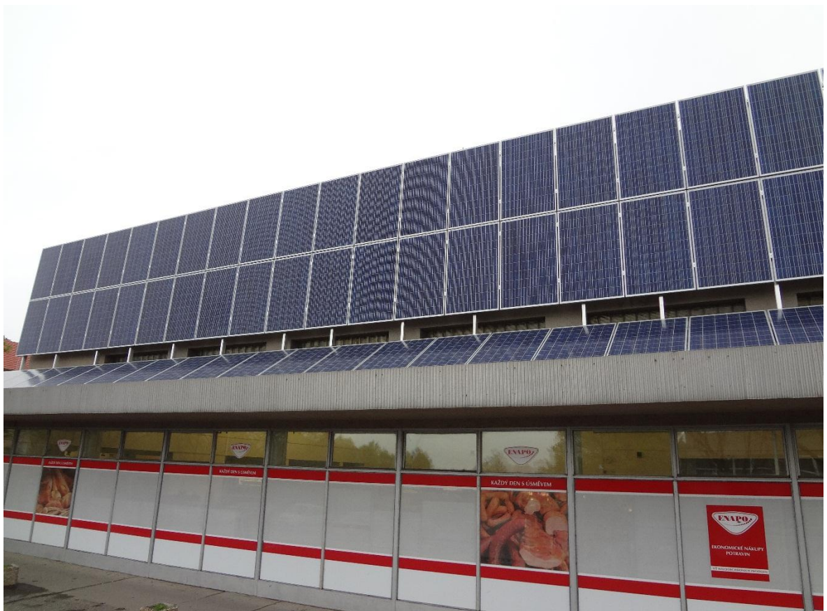
Obr.25 Fotovoltaické elektrárny fasáda
