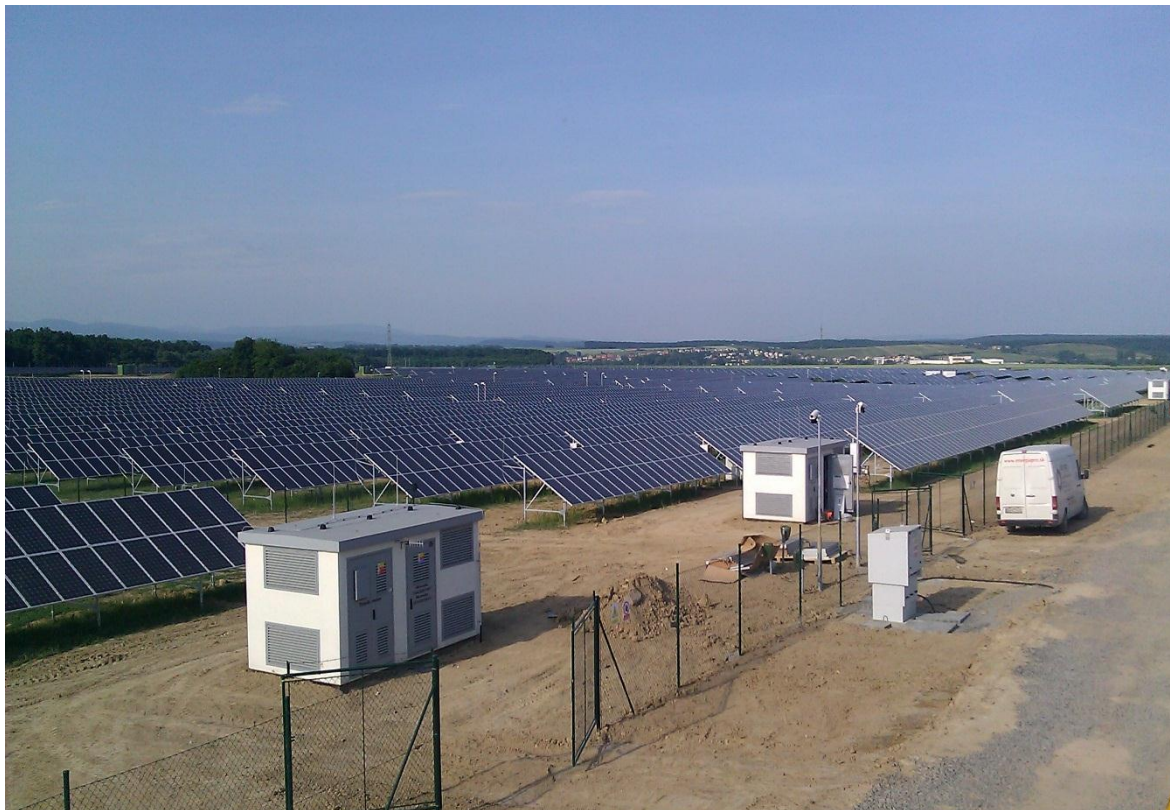
Obr. 26 – Velká fotovoltaika pole
