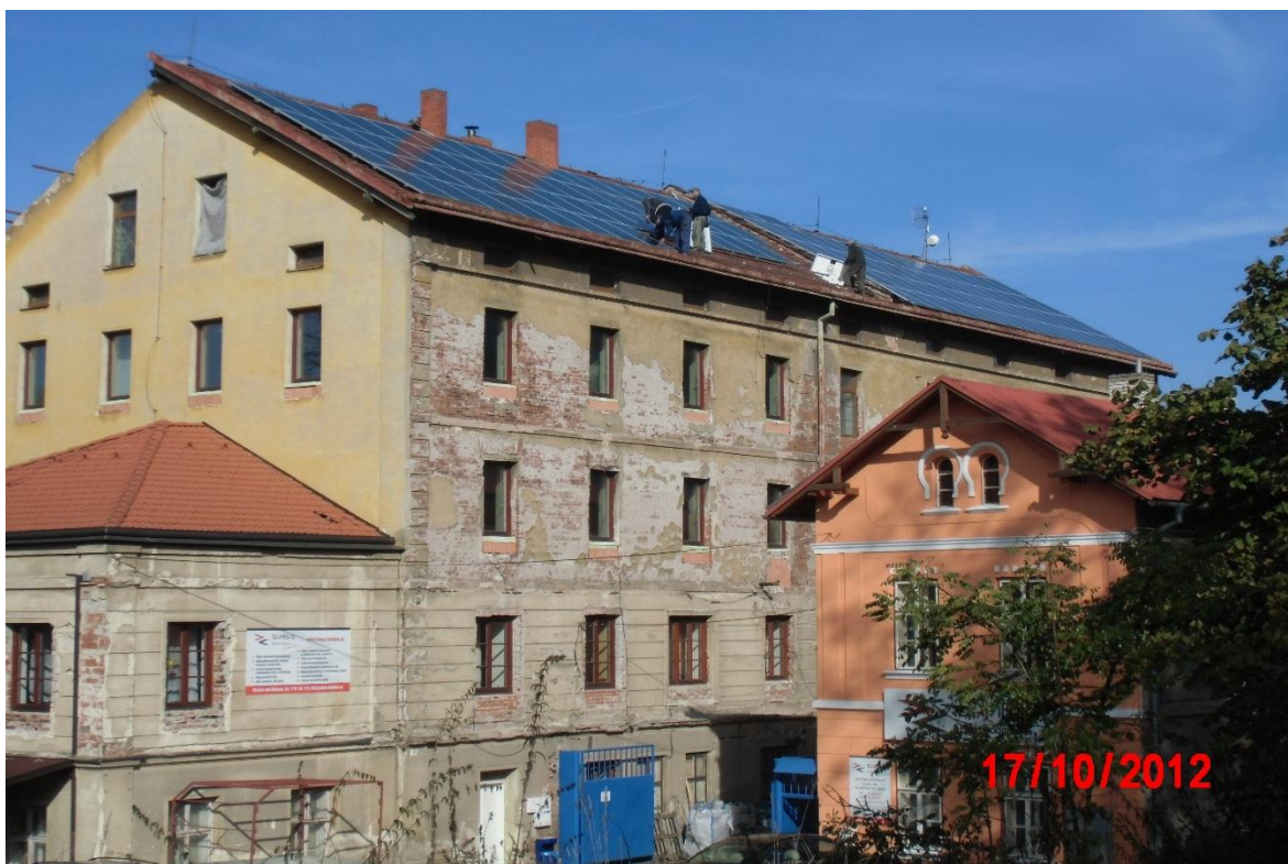
Obr. 27 – Fotovoltaická elektrárna střech
