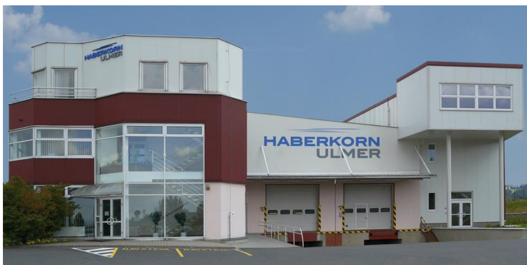
Obr. 7. Společnost Haberkorn Ulmer s.r.o. – sídlo firmy (Haberkorn Ulmer, 2014)
