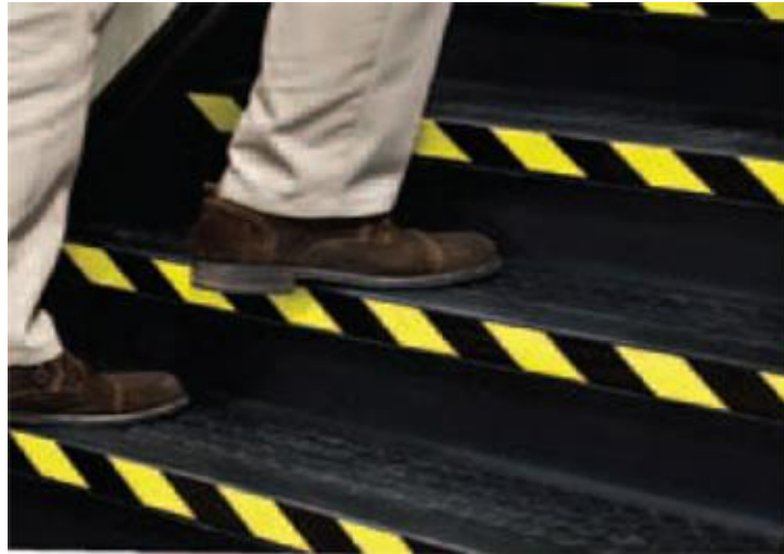
Obr. 6. Zvýraznění stupňů schodiště (Koffler Sales, © 2014)
