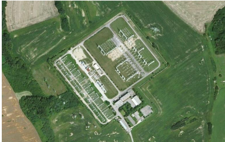
Obr. 3 Elektrická rozvodna Otrokovice 400/110kV Zdroj: https://www.google.cz/maps/preview
