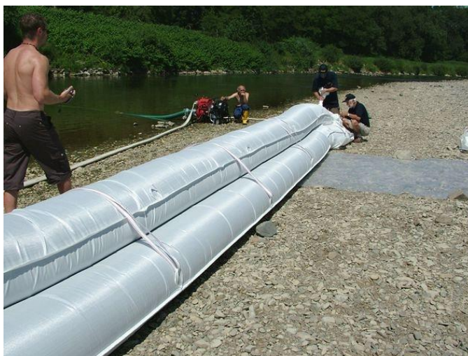
Obrázek 14 Mobilní protipovodňová bariéra [26]
