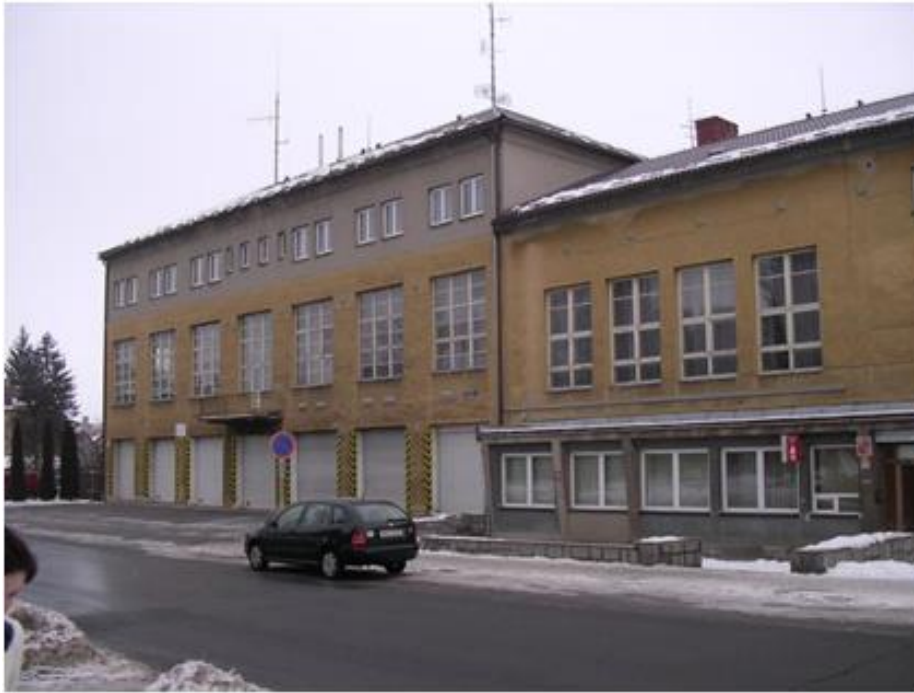
Požární stanice Šumperk
