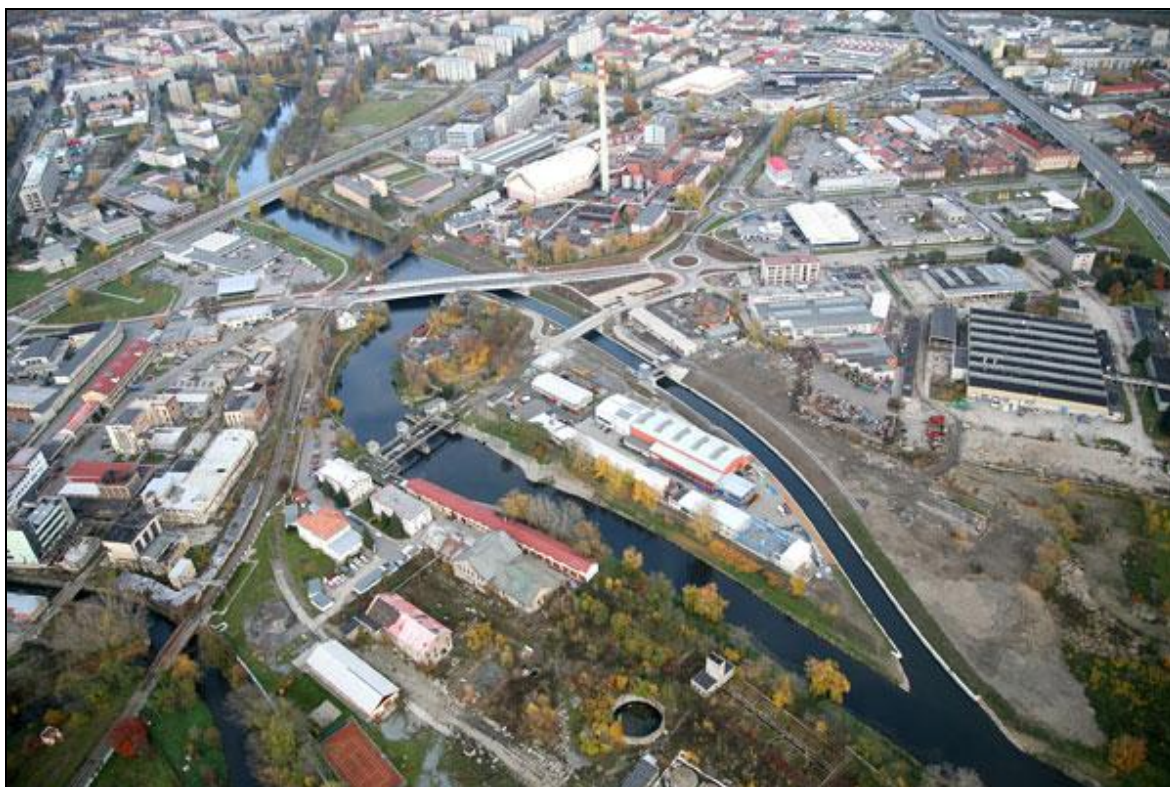
Obrázek č. 8 – Již dokončená výstavba obtokového kanálu v průtoku Salzerovy reduty [19]
