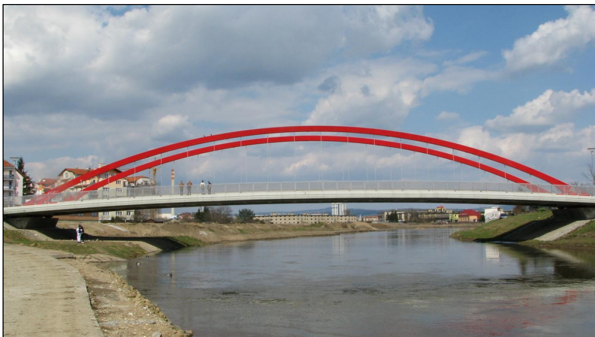
Obrázek č. 9 – Nově vybudovaný most na ulici Wittgensteinově, který je součástí I. etapy protipovodňové ochrany [19]
