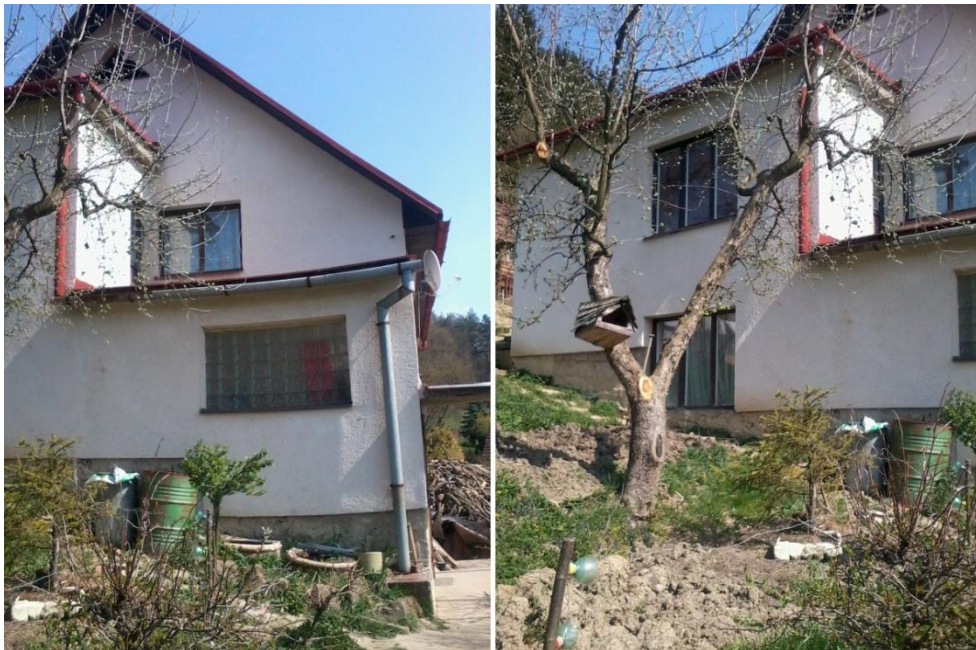
Obr. 18. Pohled na dům z jižní strany
