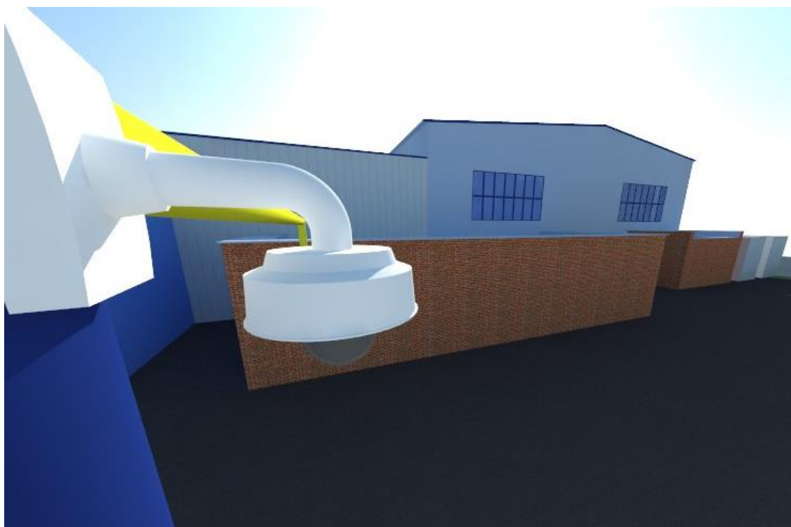
Obr. 44. Umístění Kamery 7 (Elektro rozvodna)
