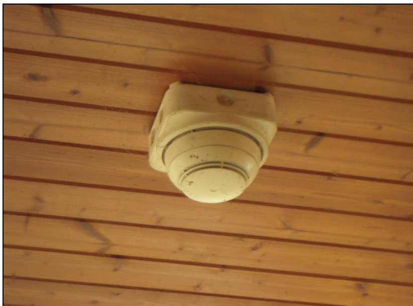
Obrázek 9 – Jedno z čidel EPS v pavilonu slonů
