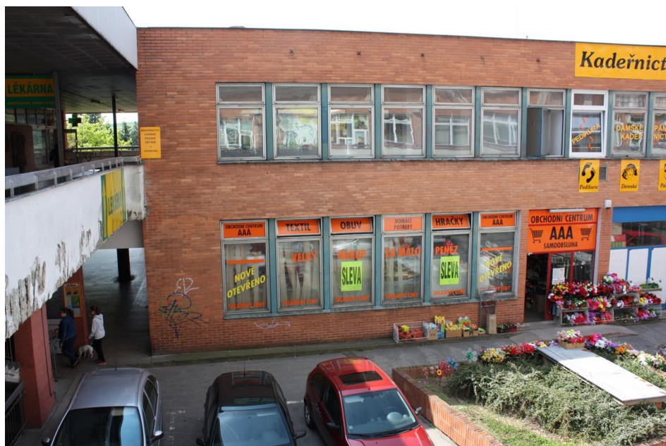
Obr. 28 Zadní strana zabezpečovaného objektu [vlastní]
