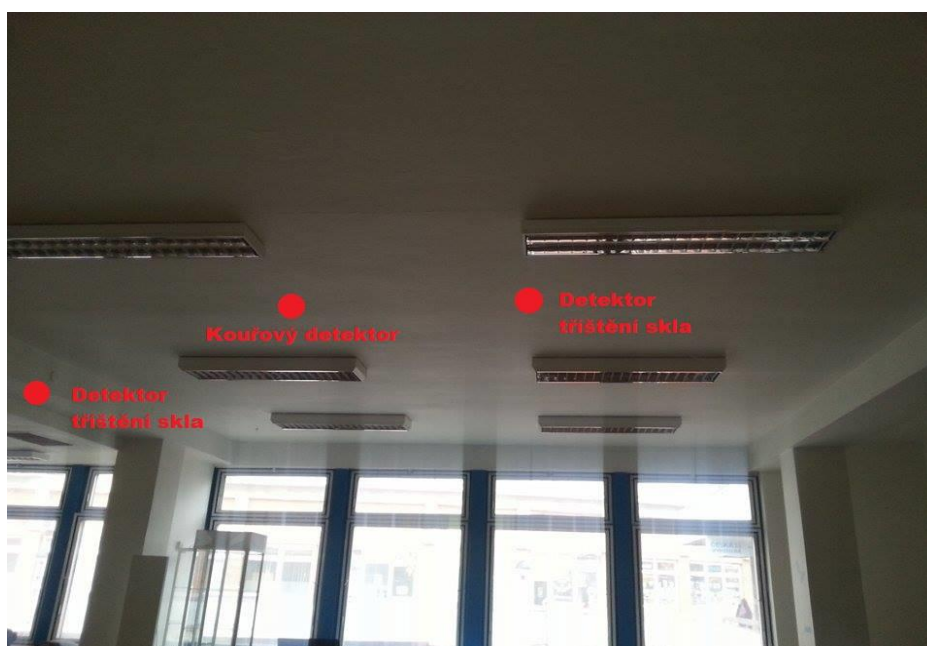
Obr. 32 Umístění detektorů tříštění skla a kouře [vlastní]
