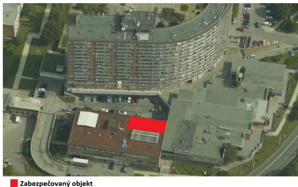
Obr. 21 Letecký pohled na střežený objekt a okolí [29]
