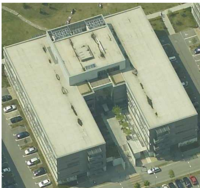
Obr. 15 – Celkový pohled na budovu
