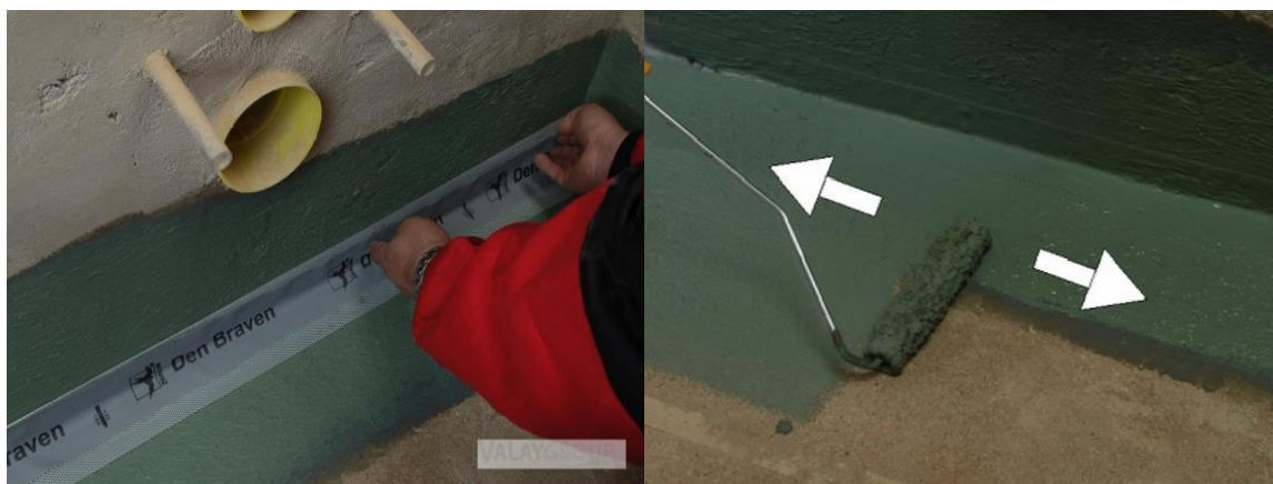
Obr. 21 – Aplikace těsnících pásů a nanášení tekuté lepenky [35]
