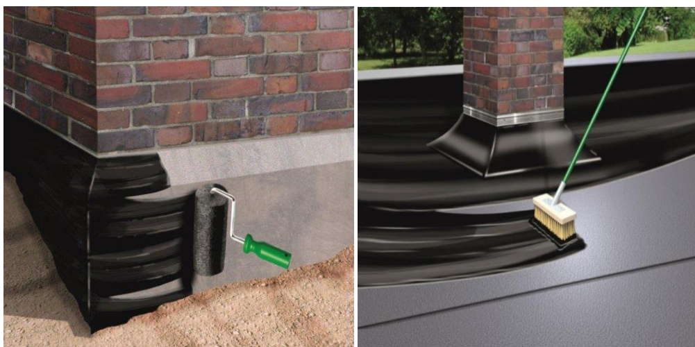
Obr. 20 – Aplikace asfaltových nátěrů [40]
