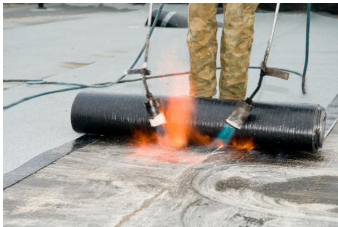
Obr. 15 – Ukázka natavování asfaltového pásu [29]
