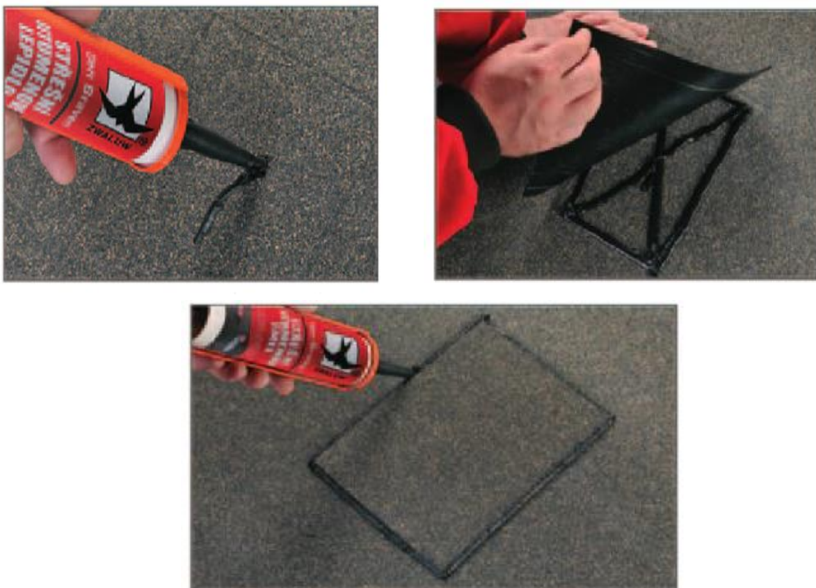
Obr. 19 – Popis opravy praskliny v asfaltové krytině [35]
