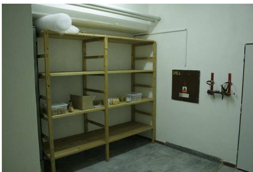
Obrázek 8: Sklad pekárny po rekonstrukci
