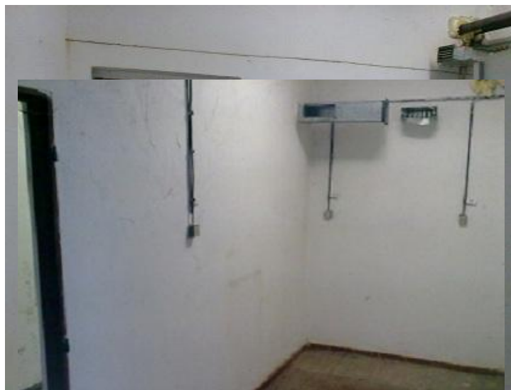
Obrázek 6: Sklad před rekonstrukcí
