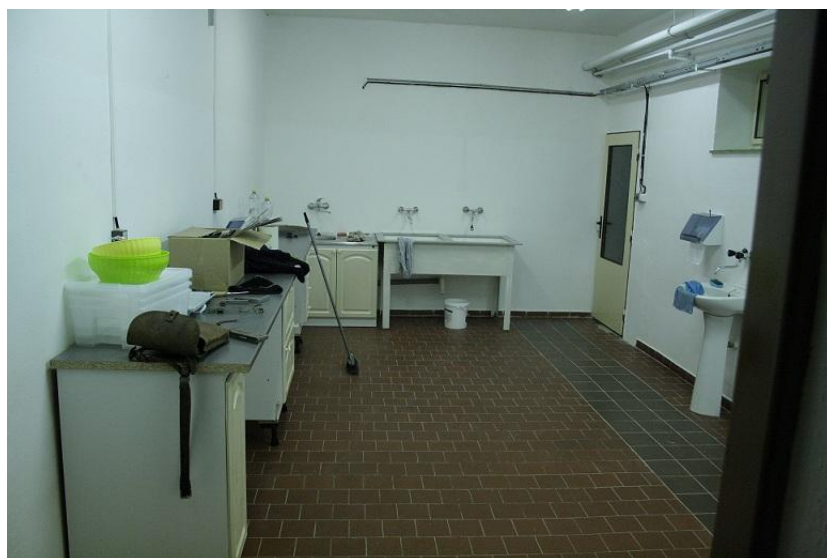
Obrázek 7: Prostor pekárny po rekonstrukci
