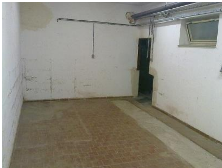
Obrázek 4: Prostor pekárny před rekonstrukcí pohled od vchodu
