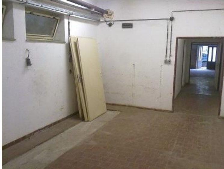
Obrázek 3: Prostor pekárny před rekonstrukcí pohled k východu
