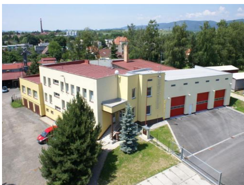
Obrázek 6 Požární stanice Lipník nad Bečvou ( interní zdroj ÚO Přerov )
