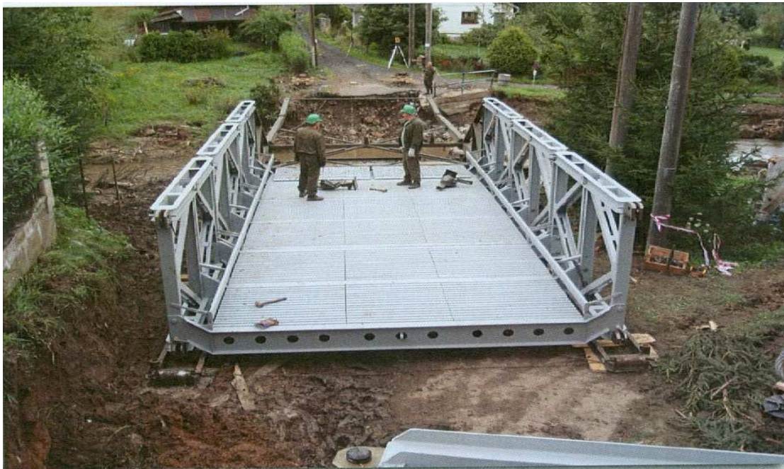
Obrázek 7: Stavba mostního provizoria [Zdroj: 5]
