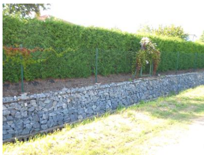
Obrázek 6: Opravená protipovodňová hráz
