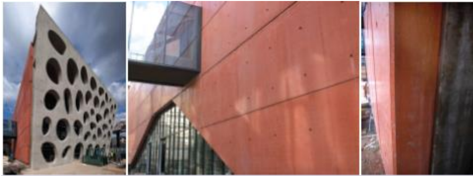
Obr.: 85. Povrchy dobarvovaného betonu. Budova divadla v Plzni
