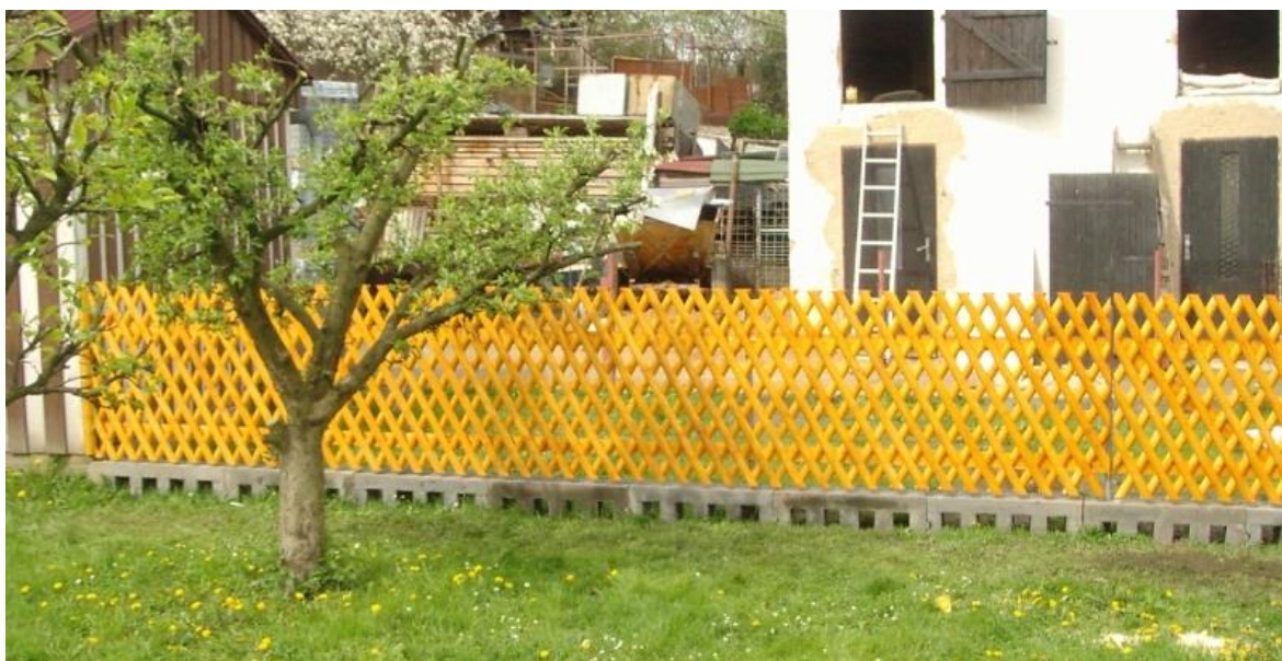
Obr.: 50. Prefabrikovaný dřevěný plot
