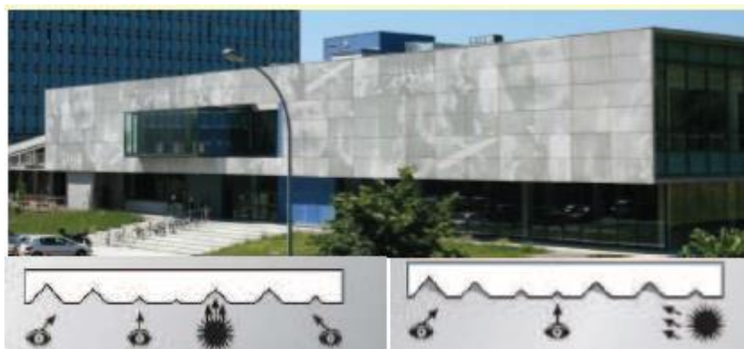
Obr.: 98. Počítačově přenesený obraz frézovací technikou na formu ze dřeva
