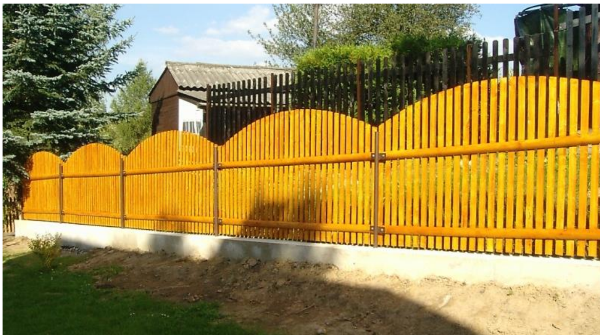
Obr.: 49. Prefabrikovaný dřevěný plot
