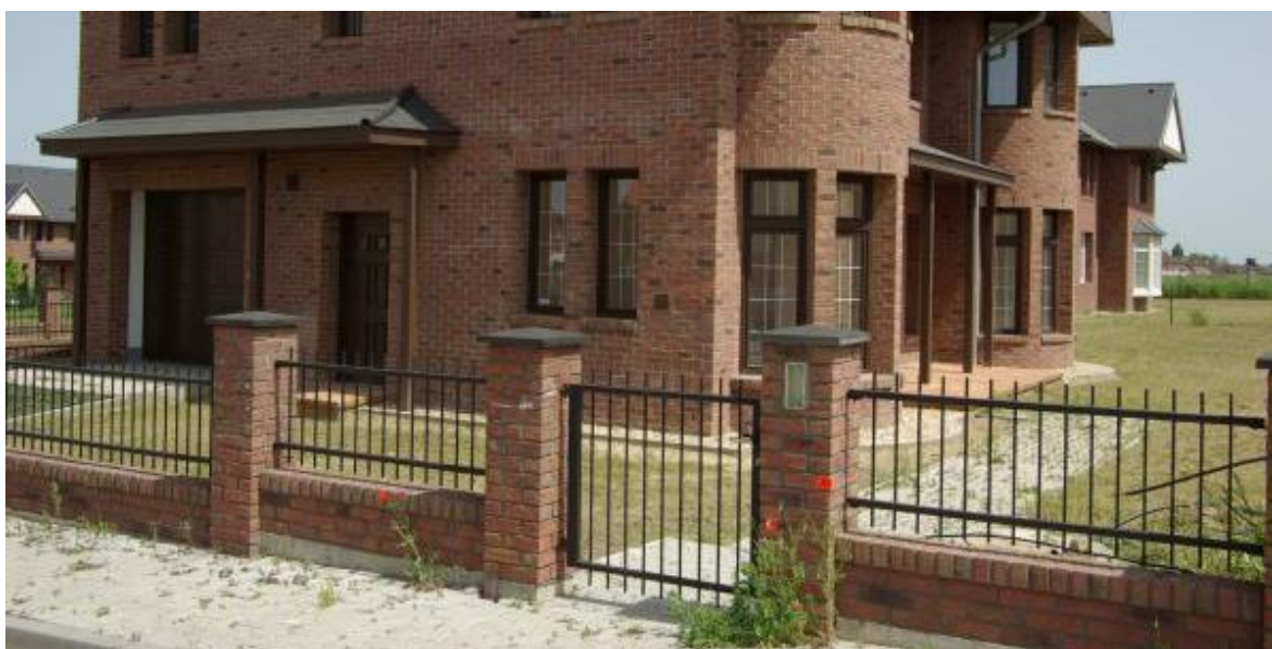
Obr.: 77. Plot ze ztraceného bednění s použitím obkladových cihelných pásek
