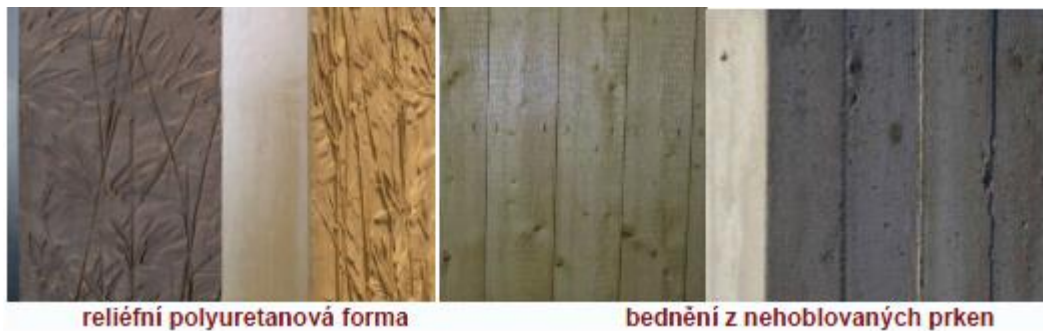
Obr.: 82. Povrch betonu vytvořený otiskem
